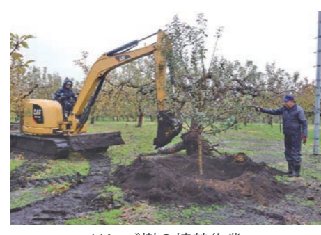
リンゴ樹の植替作業
